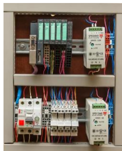
Рис. 3. Система удаленного управления подъемной установкой с модулями контроллера Vipa
